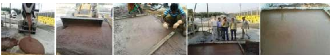
जेएसपीएल प्लाई ऐश के उपयोग से सड़क का निर्माण
